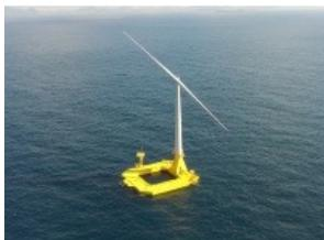
北九州沖で実証している浮体式洋上風力発電設備
